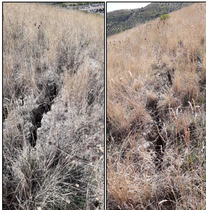
Figura 3.7 Linee di frattura rappresentative dell'area di coronamento dei corpi di frana, (Geol. Merenda, agosto 2018).
