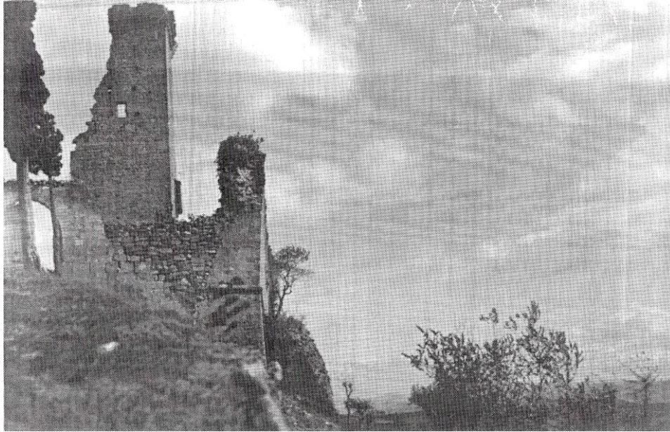
Parte della cortina occidentale e la torre danneggiata dal terremoto ASFo – Paolucci di Calboli - Barone b. 148
