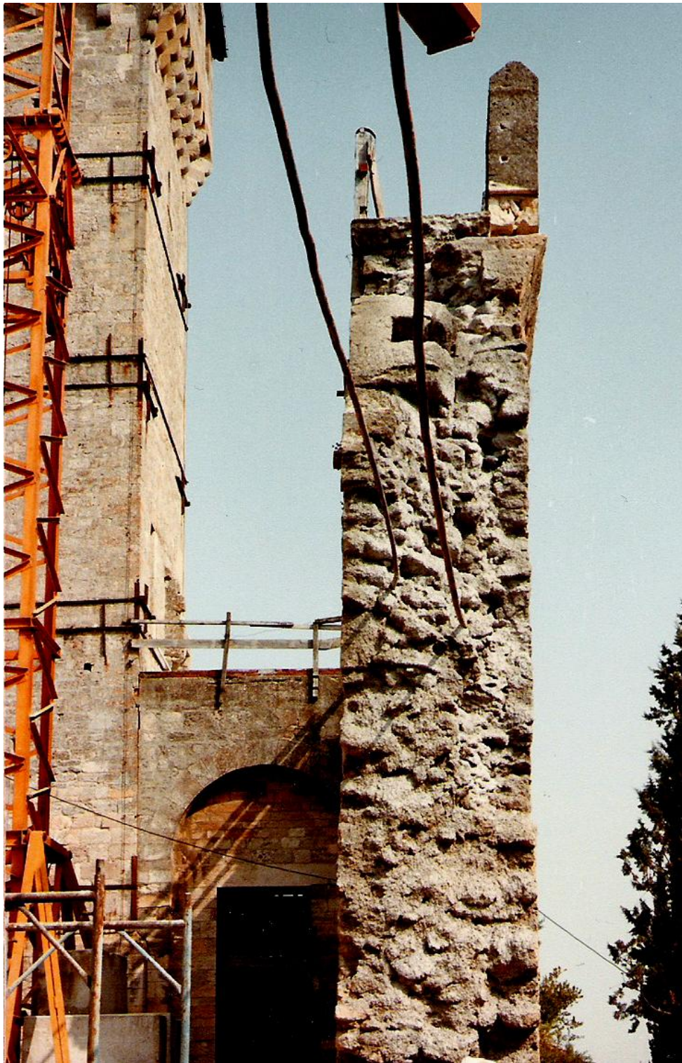
1984 – Demolizione di una parte della cortina muraria meridionale Lavori di ricostruzione di una porzione di muro
