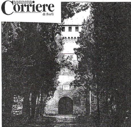
Prosegue il restauro della Rocca delle Caminate
