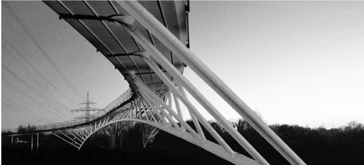
F9: http://www.rainerliebe.de/page_id=447 Vista frontale da Nord
