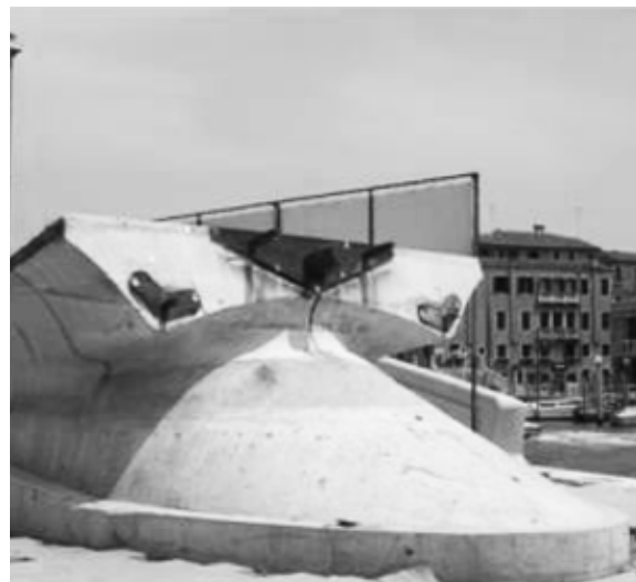
F10: G.ROMANO-C.ROMANO-L.ZIERO, Il IV ponte sul canal grande a Venezia, 2007 Fondazione N-E: i correnti superiori laterali non sono ancorati
