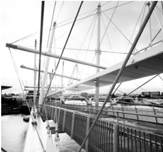
F12: http://broer.no/bro/b/b105_4.jpg Attacco dell'armatura tensegrity all'impalcato
