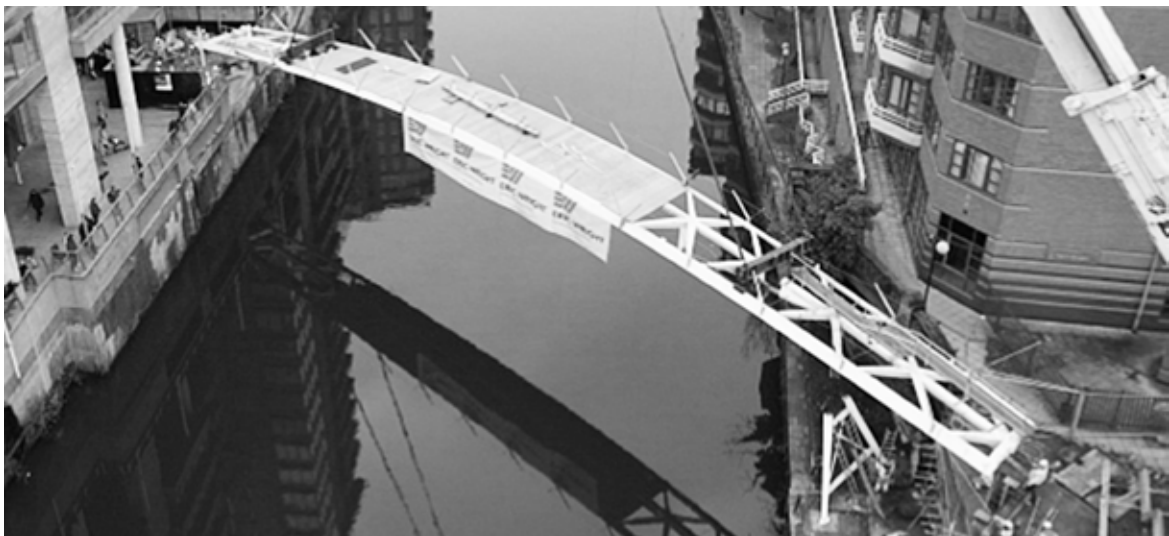
F7: http://www.suaveairphotos.co.uk/general/2/EricWrightIrwelFootbridge/ Collocamento in sede dell'intero ponte
