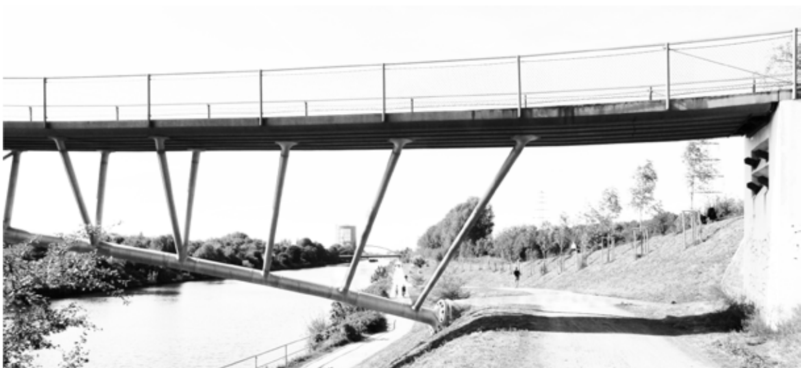
F10: https://commons.wikimedia.org/wiki/File:Oberhausen_-_Ripshorstbr%C3%BCcke_10_ies.jpg Spalla arco e appoggio impalcato Nord
