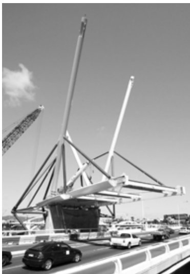
Appoggio ESTERNO N-E con supporti provvisori per incastrare l'impalcato
