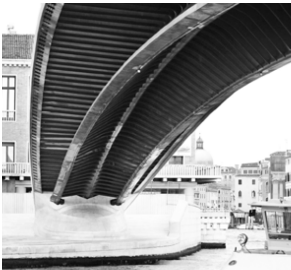
F9: http://www.calatrava.com/projects/quarto-ponte-sul-canal-grande-venezia.html Vista intradosso spalla N-O
