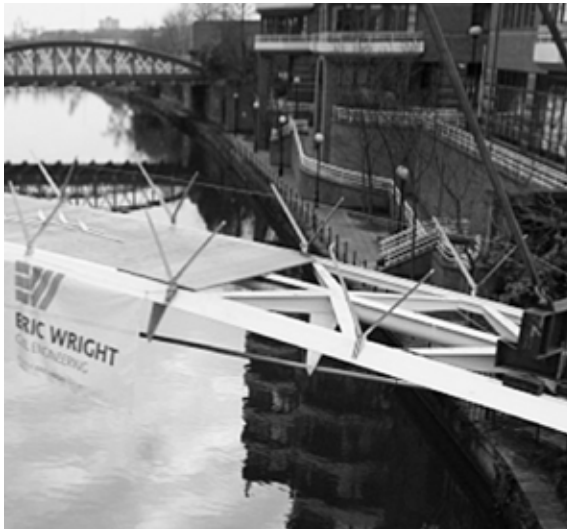
F14: http://www.suaveairphotos.co.uk/general/2/EricWrightIrwelFootbridge/Pavimentazione in fogli di alluminio di 5cm
