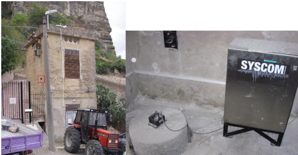
Figura 14: a) Sede della stazione sismica di Corleone, cabina ENEL "San Michele"; b) Sensori sismici installati a Corleone (Castellaro et al. , 2014).
