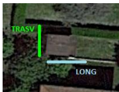
Figura 44: Foto dall'alto della cabina ENEL sita a Mirandola in via Napoli 18 ricavata da Google Earth in cui si apprezzano le diverse dimensioni nelle due direzioni.
