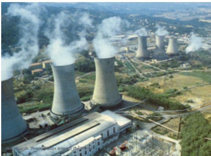
Figura 8: Torri di raffreddamento nel campo geotermico di Larderello, da http://bellenergia.altervista.org/PRINCIP_GEOTERMIA.htm
