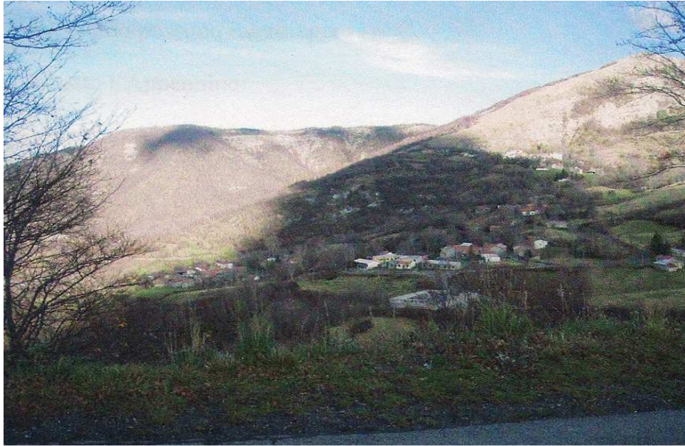
Fig. 2.4: Foto panoramica scattata da Varvilla (Succiso Nuova). Si riconoscono a sinistra Succiso Inferiore e più a destra Succiso di Mezzo, sopra la quale si scorge Succiso Superiore ai piedi di “La Borellaccia”
