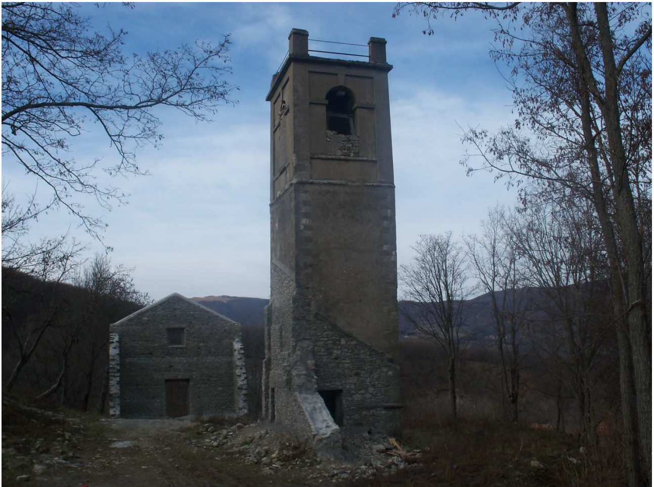
Fig. 4.2, 4.3, 4.4: Fotografie relative alla chiesa di Succiso di Mezzo, distrutta durante la fase di massima intensità dei dissesti (oggi ne restano soltanto la facciata e il campanile).
