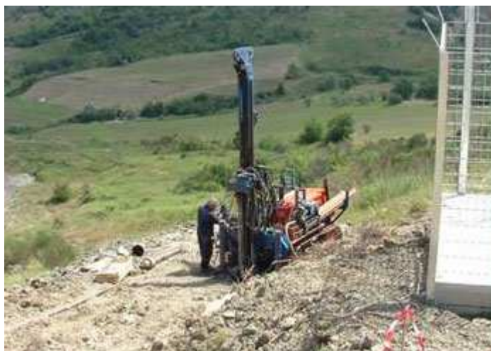
Fig. 8.1: Sondaggio a carotaggio continuo
