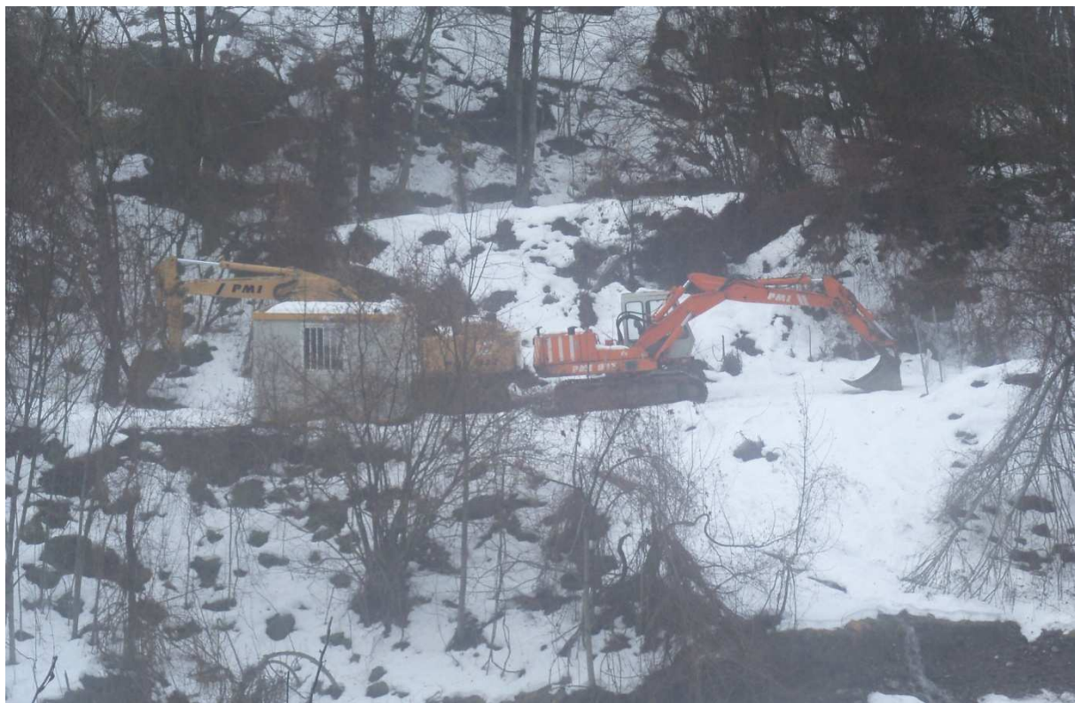
Fig. 5.16: Area di cantiere a valle di Succiso Inferiore
