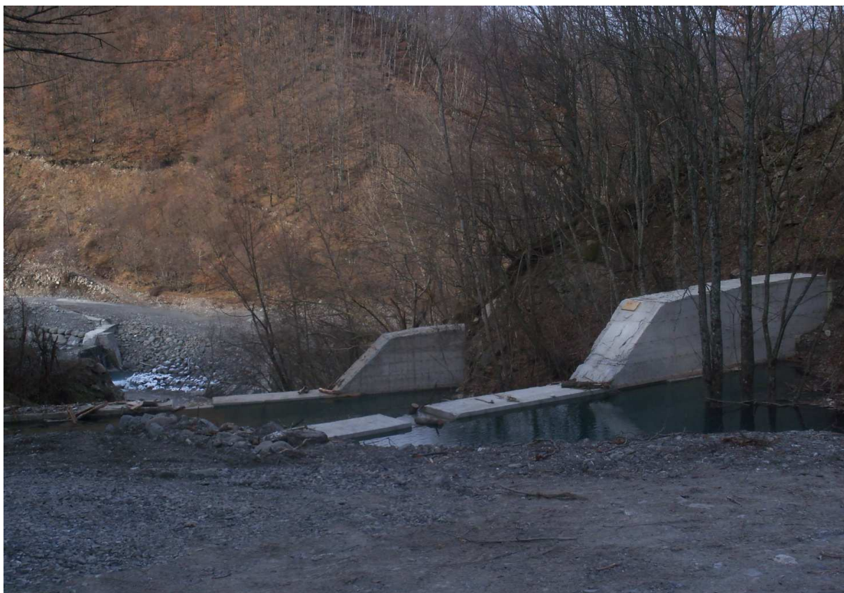
Fig. 5.17: Stato di avanzamento lavori sul tratto in esame del Rio Marzolaro (fotografia scattata il 15/12/2010)
