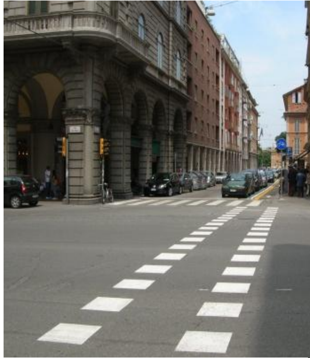
Figura 1.6 Attraversamento ciclabile (via Dei Mille, Bologna)
