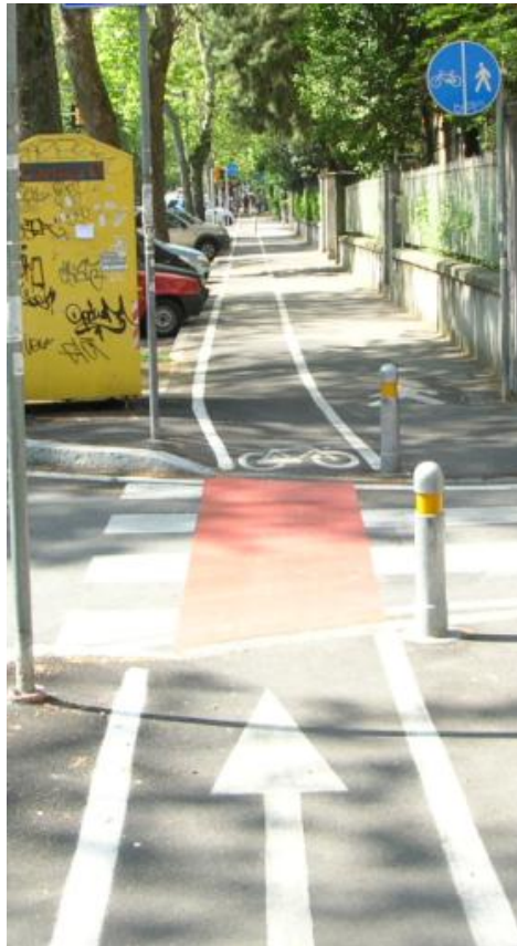
Figura 1.4 Pista ciclabile su corsia riservata ricavata dal marciapiede (via Mengoli, Bologna)
