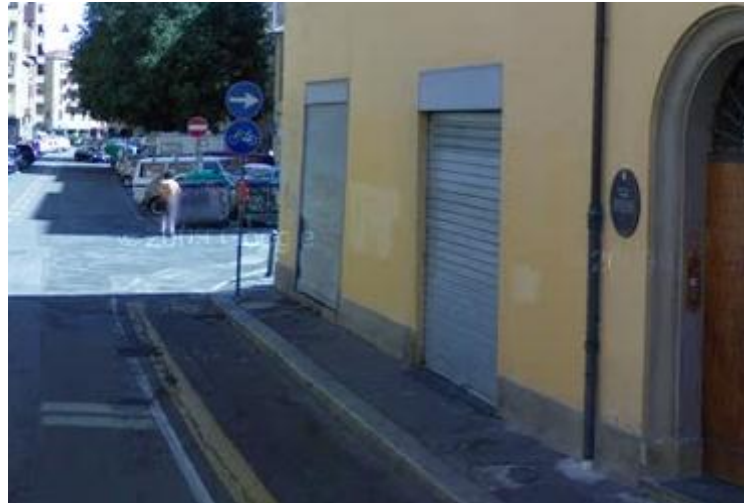
Figura 4.15 Pista ciclabile su corsia riservata in carreggiata separata dalla corsia di marcia tramite strisce longitudinali sulla pavimentazione
