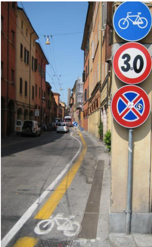
Figura 1.2 Pista ciclabile su corsia riservata separata dalla corsia di marcia tramite striscia longitudinale (via San Vitale, Bologna)
