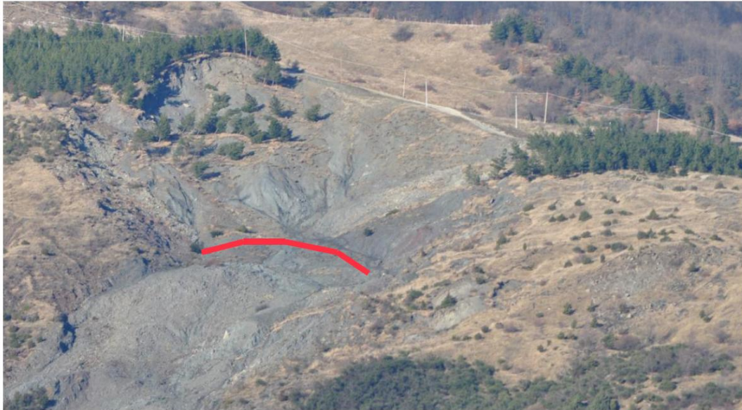
Fig. 7.2 - Nicchia della frana con ubicazione alla base della paratia su pali ipotizzata. La morfologia della nicchia è aggiornata a dicembre 2010.
