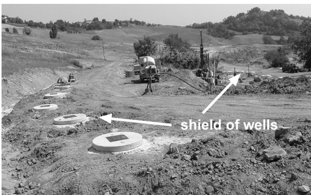
Fig. 7.5 e 7.6 – Foto di schermi di pozzi drenanti a monte della paratia
