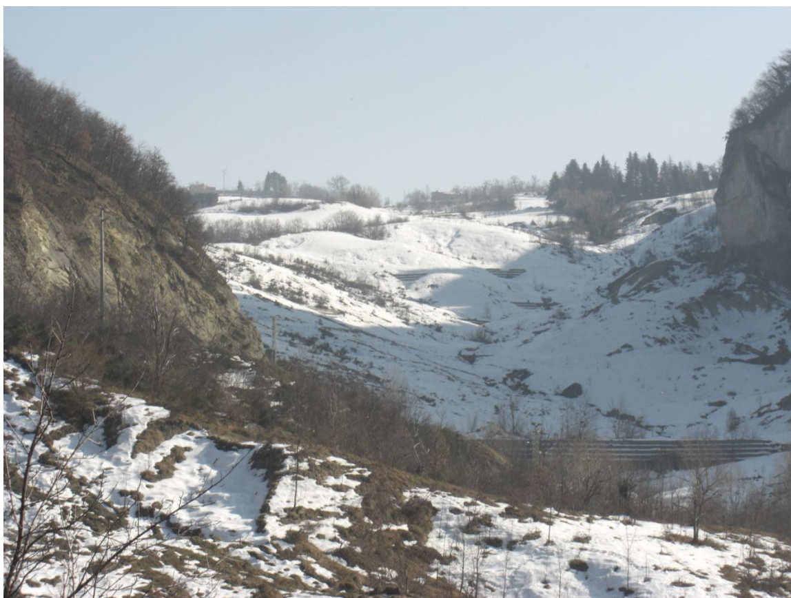
Figura 1.14 Fotografia di un'area in dissesto attivo (San Leo, RN) presso il Fosso Campone (San Leo)
