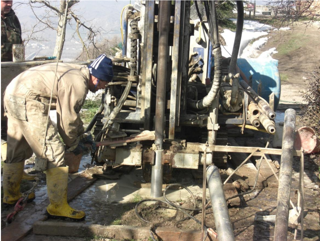
Figura 3.3 Realizzazione di un carotaggio con sistema a rotazione
