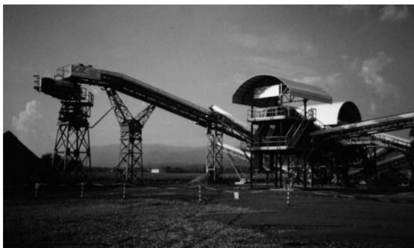
Fig. 1.12 Impianto fisso con applicazione della tecnologia ROSE in Località Albinatico-Ponte Buggianese
