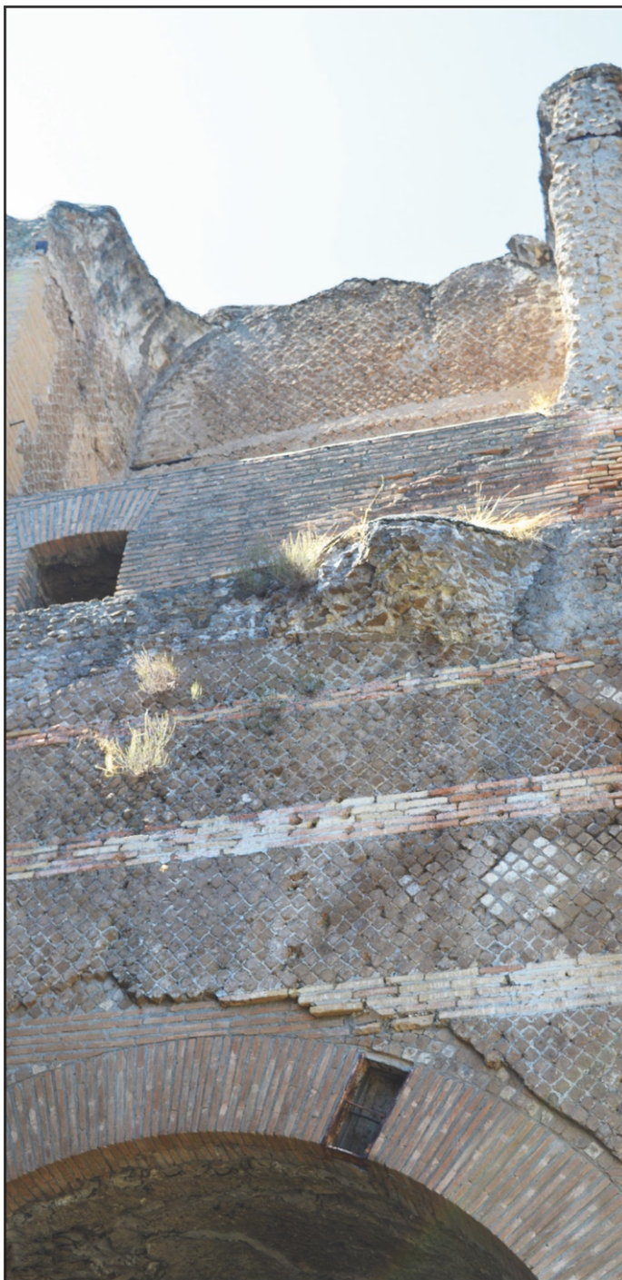
Figura 73: Struttura muraria della Biblioteca Greca di Villa Adriana.
