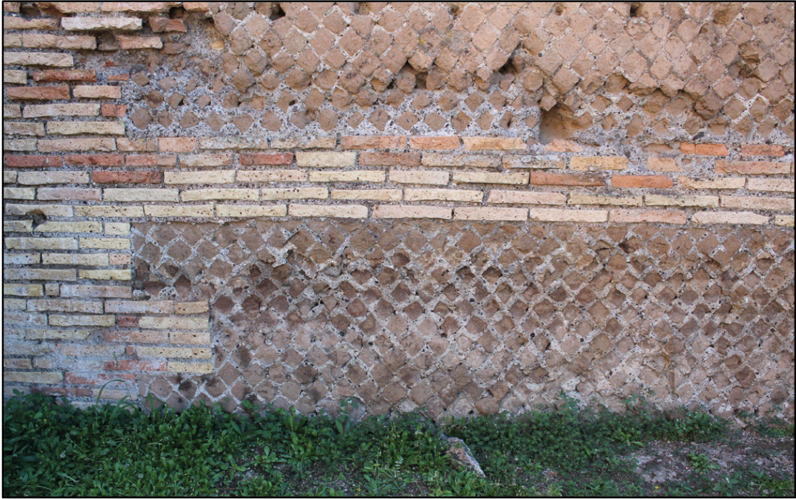
Figura 74: Struttura muraria della Biblioteca Greca di Villa Adriana.
