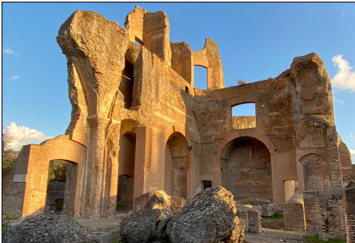
Figura 17: Vista frontale lato sud Biblioteca Greca, Villa Adriana, Tivoli.
