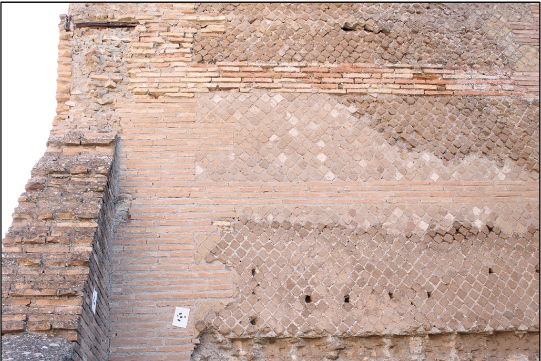
Figura 75: Struttura muraria della Biblioteca Greca di Villa Adriana.
