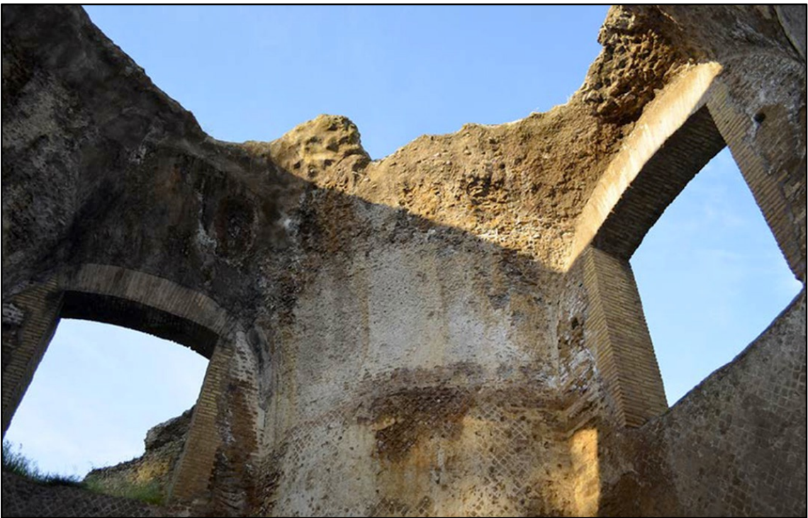
Figura 10: Dettaglio della copertura della sala ottagonale delle Piccole Terme.
