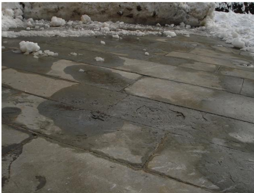
Figura 31 pietra di Bagno di Romagna in corso Umberto I
