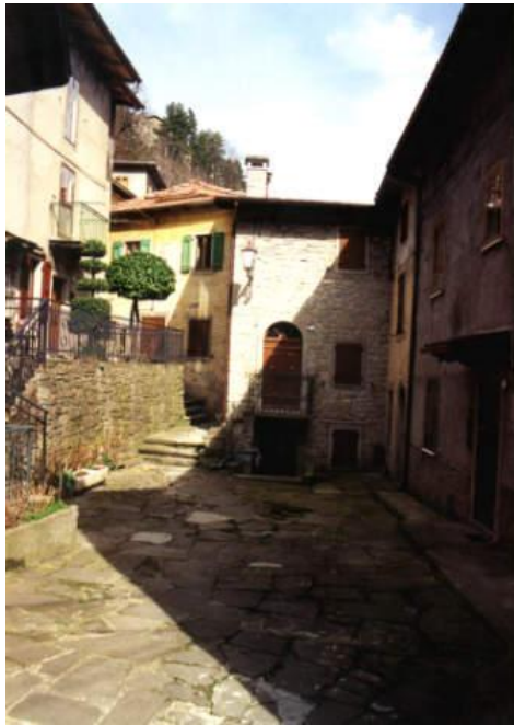
Figura 38 Ara delle Lucciole con la vecchia pavimentazione
