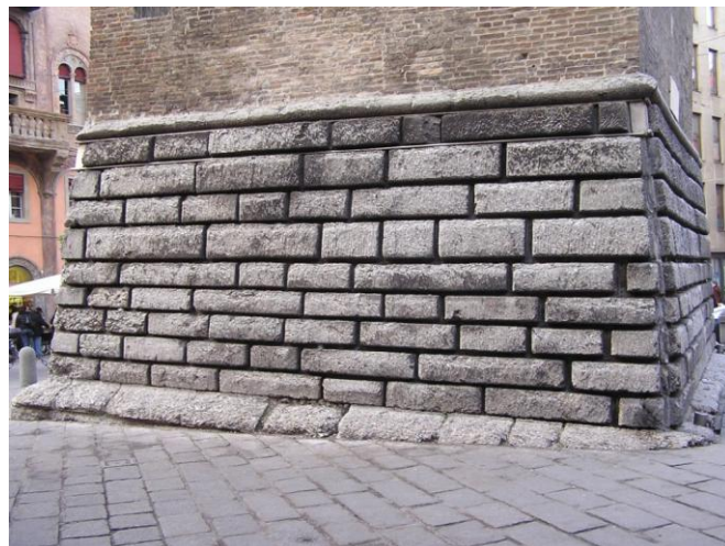
Figura 19 Basamento in gesso della Torre della Garisenda a Bologna
