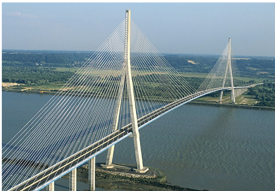
Figura 1.1 – ponte strallato stradale
