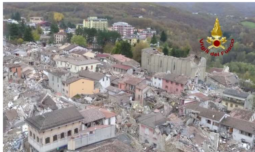
Figura 4.15: Ripresa aerea da drone dei Vigili del Fuoco di Amatrice (RI) post-sisma 2016 - www.rietinvetrina.it [9]
