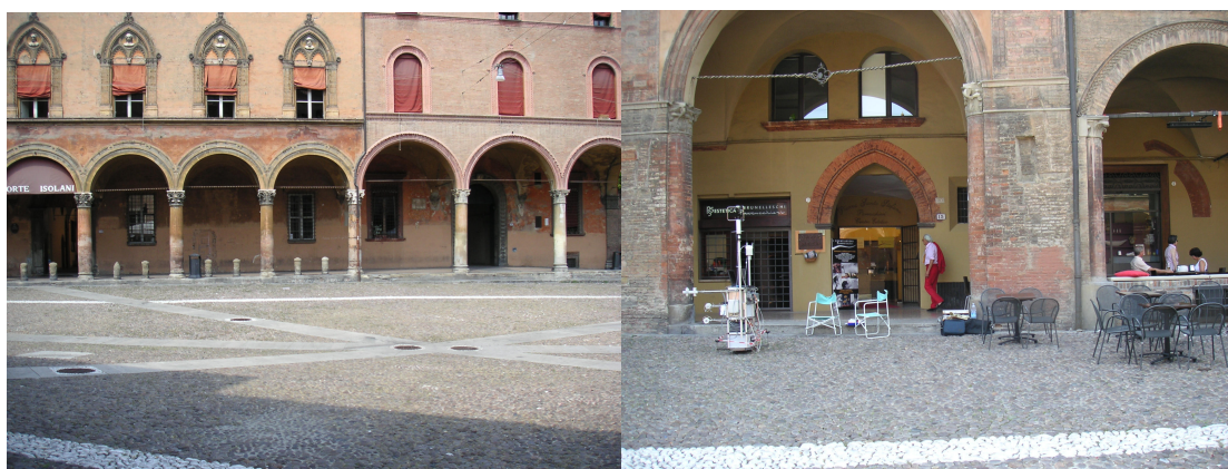
Fig. 7.23 e Fig. 7.24: Istantanee della stazione di Piazza S. Stefano che mostrano la piazza (a sinistra, Fig. 7.23) e il posizionamento della strumentazione (Fig. 7.24 a destra).
