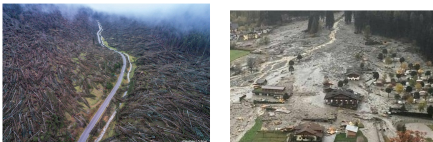
Figura 3.1: Danni provocati dall'eccezionale intensità dei venti e delle piogge nelle regioni del Triveneto durante la tempesta Vaia (27-30 ottobre 2018).
