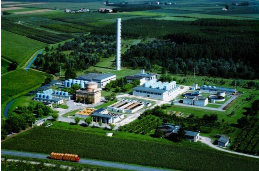
Figura 12 - Centrale di potabilizzazione di Ro Ferrarese (FE) (CADF S.p.A., 2019)
