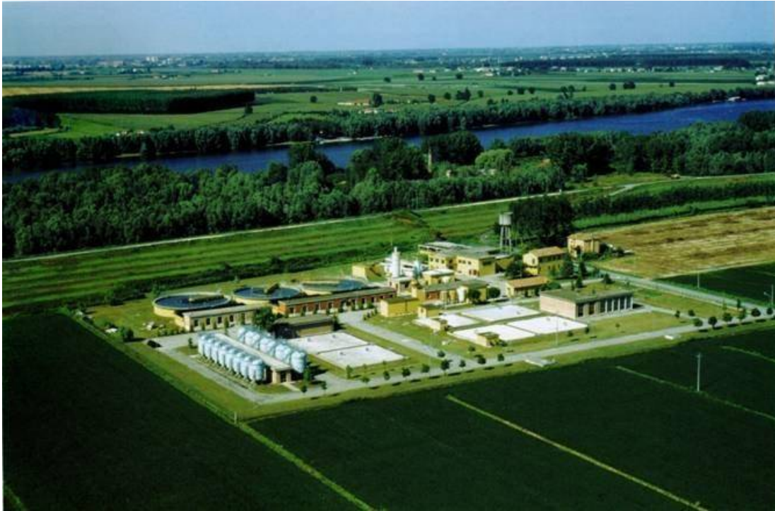
Figura 11 - Centrale di potabilizzazione di Serravalle (FE) (CADF S.p.A., 2019)
