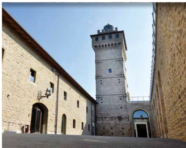
Figura 8.6: Rocca delle Caminate: corte interna
