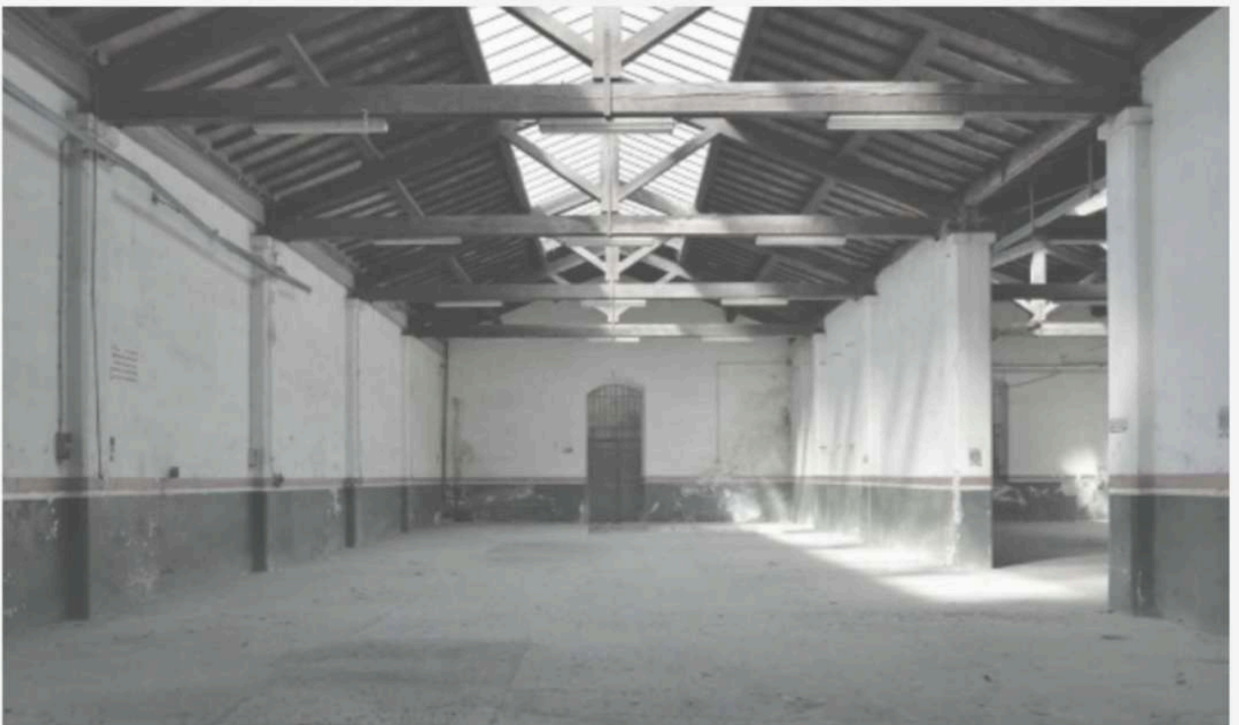
Da sinistra verso destra e dall'alto verso il basso: _ vista della facciata su via Carradori _ vista dell'alto prima e dopo i crolli dovuti alla tempesta di vento del 5 marzo 2015 _ interno di uno dei capannoni industriali ad un piano
