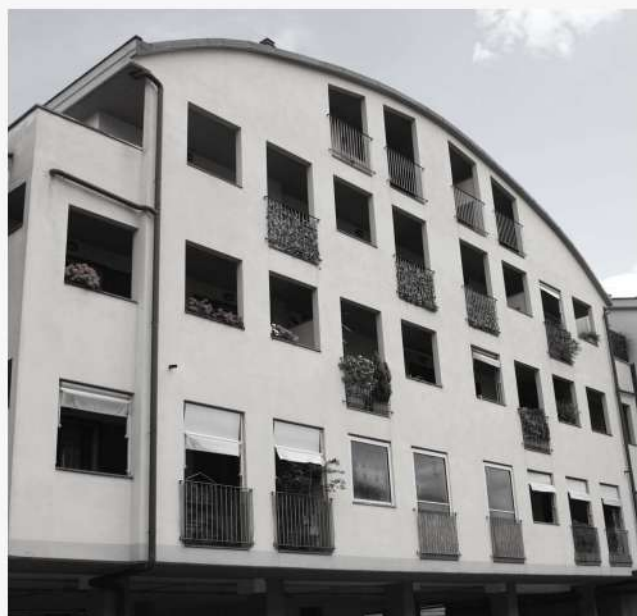
Ristrutturazione con destinazione residenziale in via Bologna
