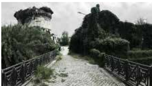
Fig. 2 Vista del Ponte Lucano, scattata durante il sopralluogo.
