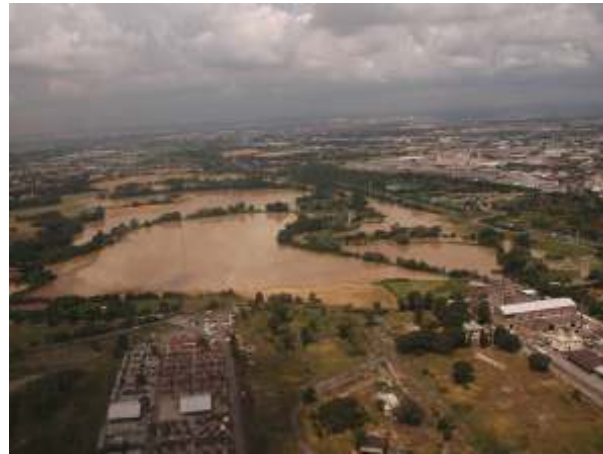
Fig. 16: Vista a volo d'uccello sul territorio del comune di Tivoli durante l'esondazione dell'Aniene, del 21 maggio 2008.
