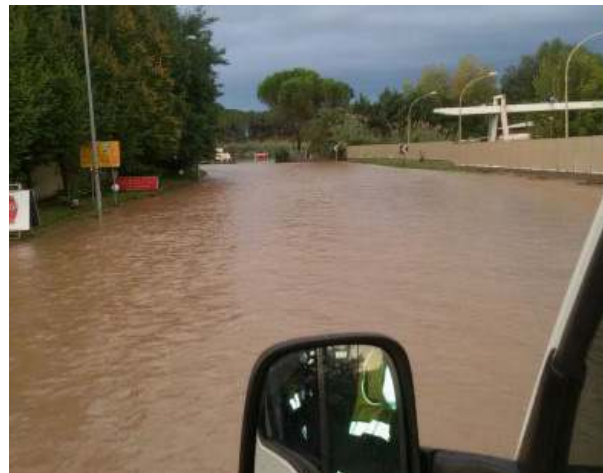
Fig. 17: Via Maremmana Inferiore durante l'esondazione dell'Aniene del 21 maggio 2008, con danni che precludono la fruibilità dell'assetto viario.
