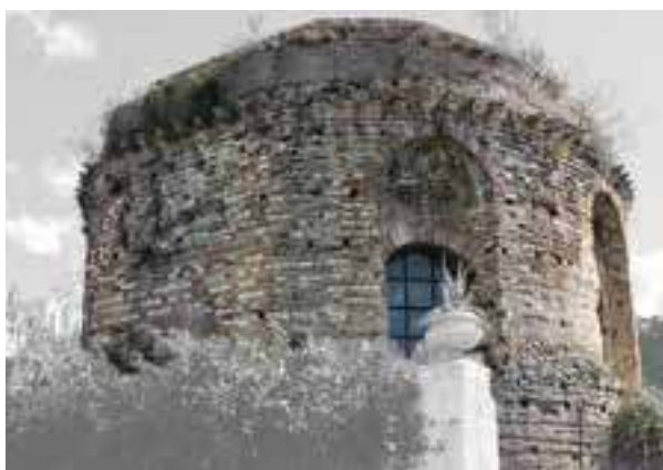
Fig. 5 Vista del Tempio della Tosse, scattata durante il sopralluogo.
