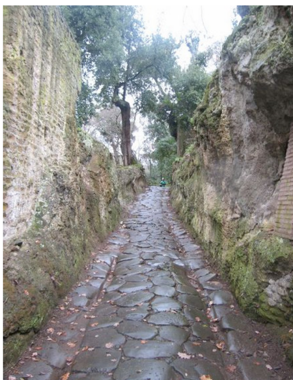
Fig. 12 Tratto di strada basolata che permette l'accesso alla c.d. Terrazza di Tempe. Fonte: www.fastionline.org, FOLDER-it-2010-190.
