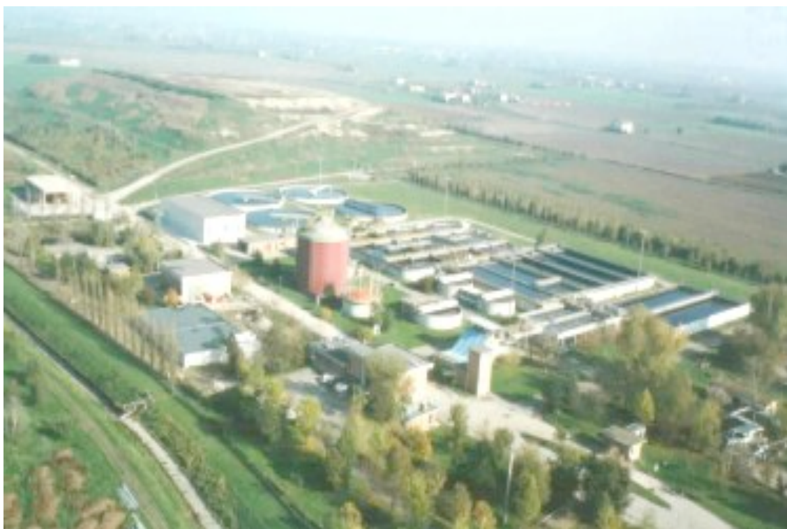
fig. 2.1 Impianto di depurazione di Carpi
