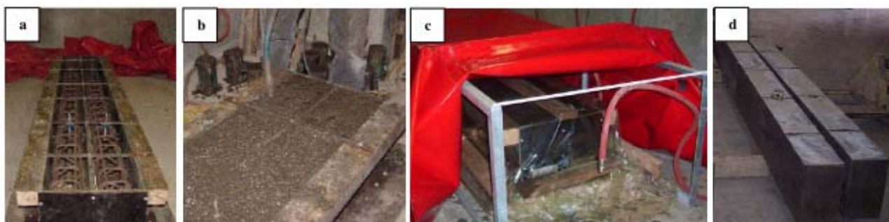
Figura 1.19 Produzione di architravi: a) stampo con gabbia di rinforzo; b) compattazione; c) riscaldamento; d) architravi.
