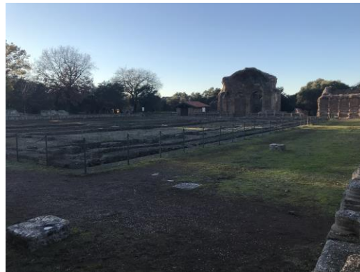
Fig. 2.14. Vista lato sud-est della zona centrale
