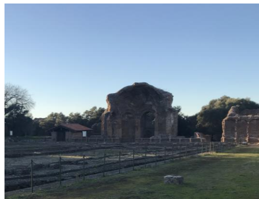
Fig. 2.9. Fronte del Vestibolo ripresa da nord-est
