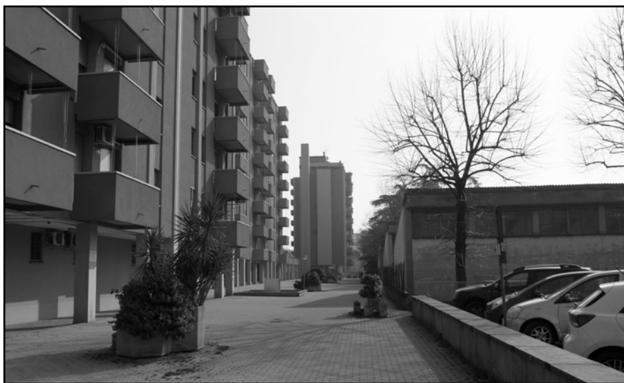
Accessi alla corte da via Vittoria
