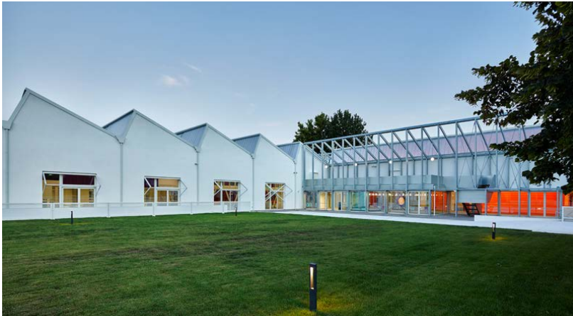
STRUTTURA IN ACCIAIO
