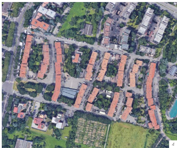
5 FOTO AEREA DEL COMPLESSO INA-CASA "DUE MADONNE"
