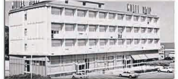
Unico caso realizzato a Savona agli inizi degli anni '60 con blocchi in cemento pre-fabbricati per accelerare le tempistiche di costruzione.
