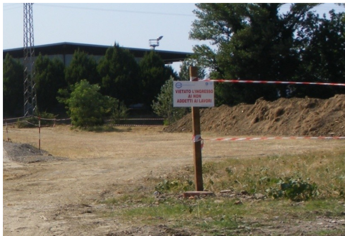
Fig. 4.16: Accesso al cantiere e dotazioni di sicurezza fornite da C.A.R.
