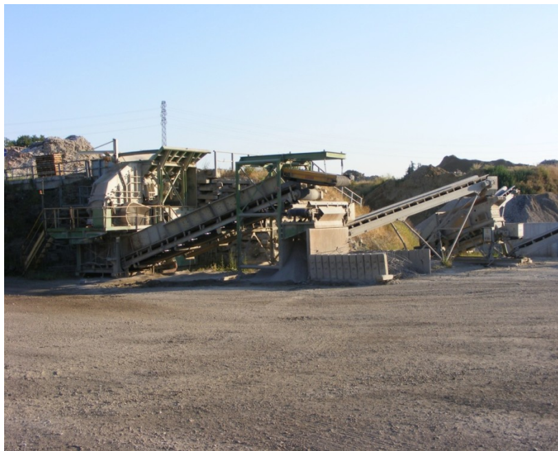
Fig. 1.1 – frantoio semifisso: impianto di proprietà C.A.R.
