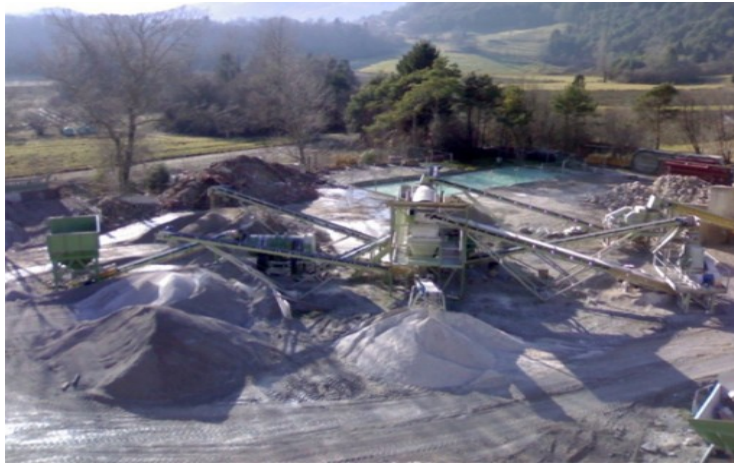
Figura 1.3: Impianto fisso per il riciclaggio dei rifiuti da C&D.
