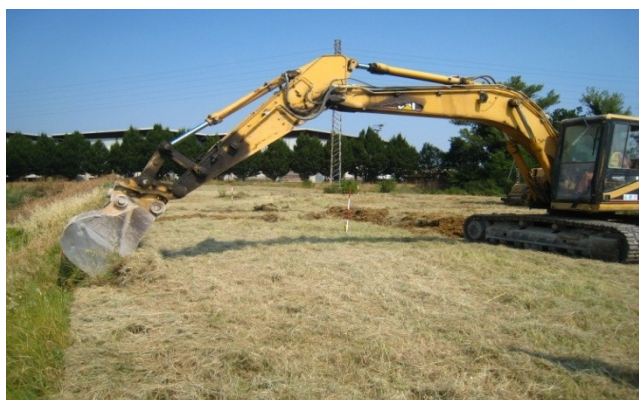
Fig. 4.18: Scavo dei fossi di scolo.
