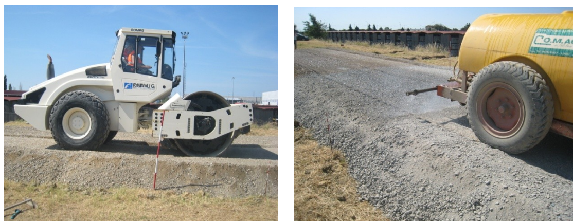
Fig. 4.30: A sinistra, prima rullatura; a destra, umidificazione precedente a seconda rullatura.
