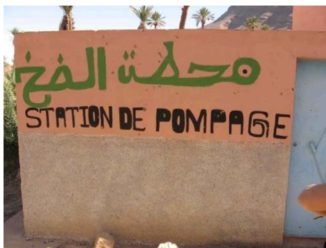
Stazione di pompaggio di Ouiftout
