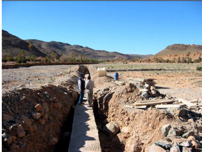
Ristrutturazione di una khattara in una zona vicina a quella di intervento
