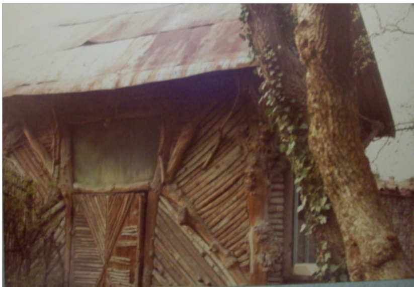
Fig. 3 – Faenza, Capanno rustico, con copertura in lamiera. (A.F.B.A.A. RA n. 37449)
