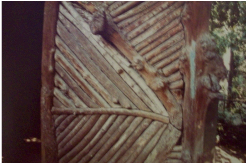
Fig. 5 – Faenza, Capanno rustico, struttura lignea prima del trattamento (A.F.B.A.A. RA n. 37508)
