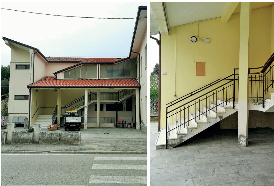
Figura 6.7, Figura 6.8 - Vista esterna lato Nord-Ovest: dettaglio dell'ingresso
