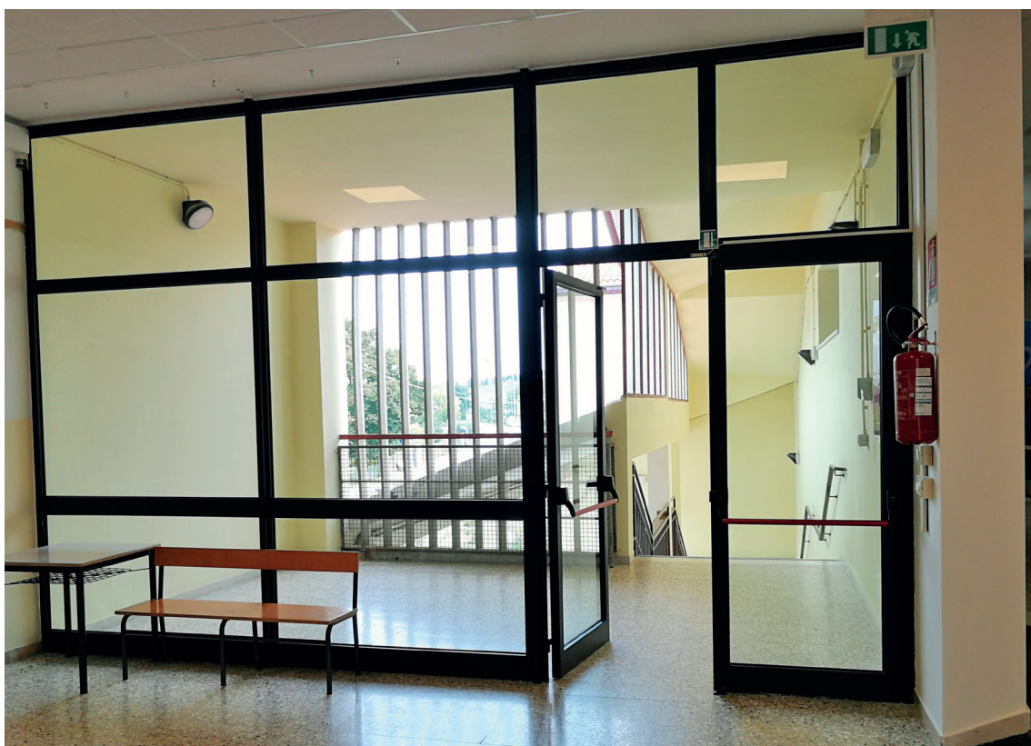
Figura 6.13 - Dettaglio dell'unica uscita di sicurezza presente al primo piano
