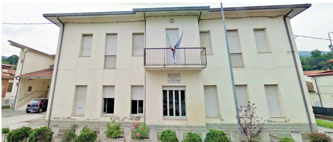
Figura 6.6 - Vista esterna lato Ovest: nucleo principale dell'edificio
