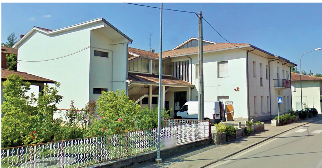
Figura 6.4 - Vista esterna lato Nord
