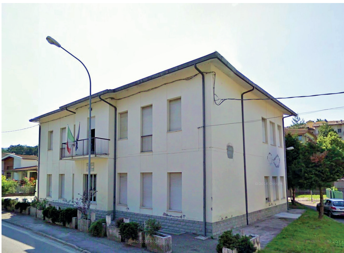
Figura 6.9 - Vista esterna lato Sud-Ovest
