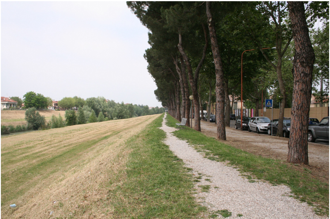
Fig. 048 – Argine destro del fiume Savio
