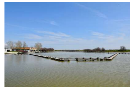
Lavoriero in cemento, marzo 2018
