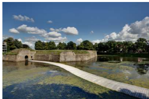
Ro&Ad, Ravelijbrug, Le Grandstraat, Olanda
