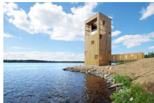
OOPEAA, Periscope Tower, Finlandia
