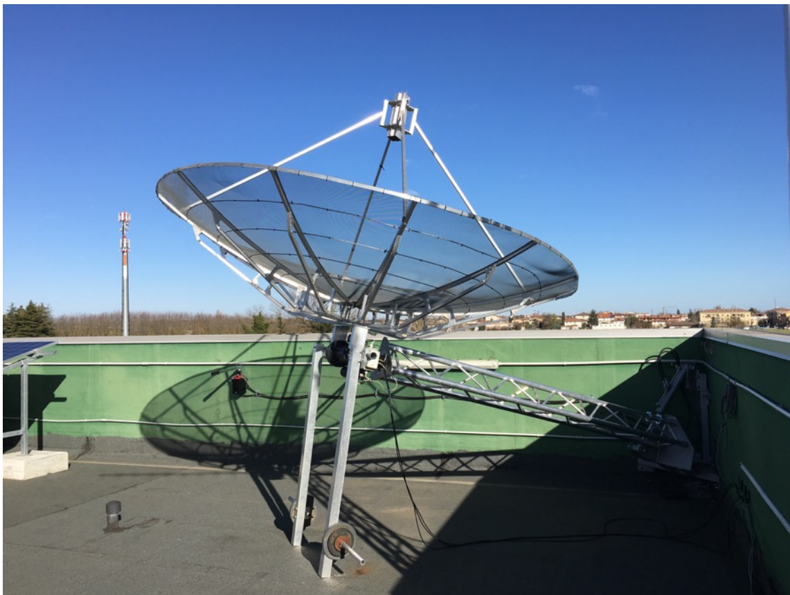
Fig. 2.15: Movimentazione traliccio e posizionamento parabola
