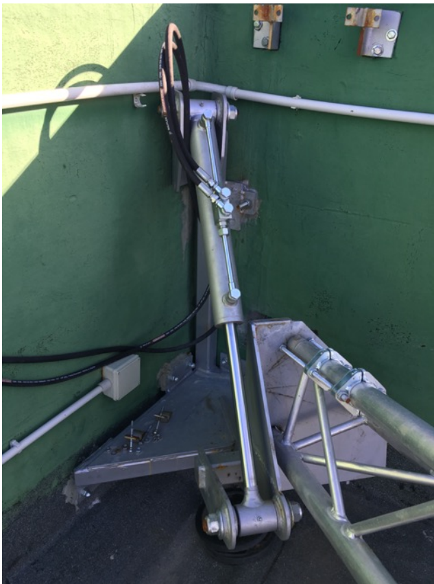
Fig. 2.13: Sistema idraulico alla base del traliccio estratto
