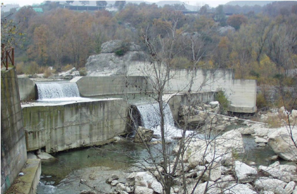
Figura 3 – Esempio di regimazione fluviale con briglie sul F. Marecchia
