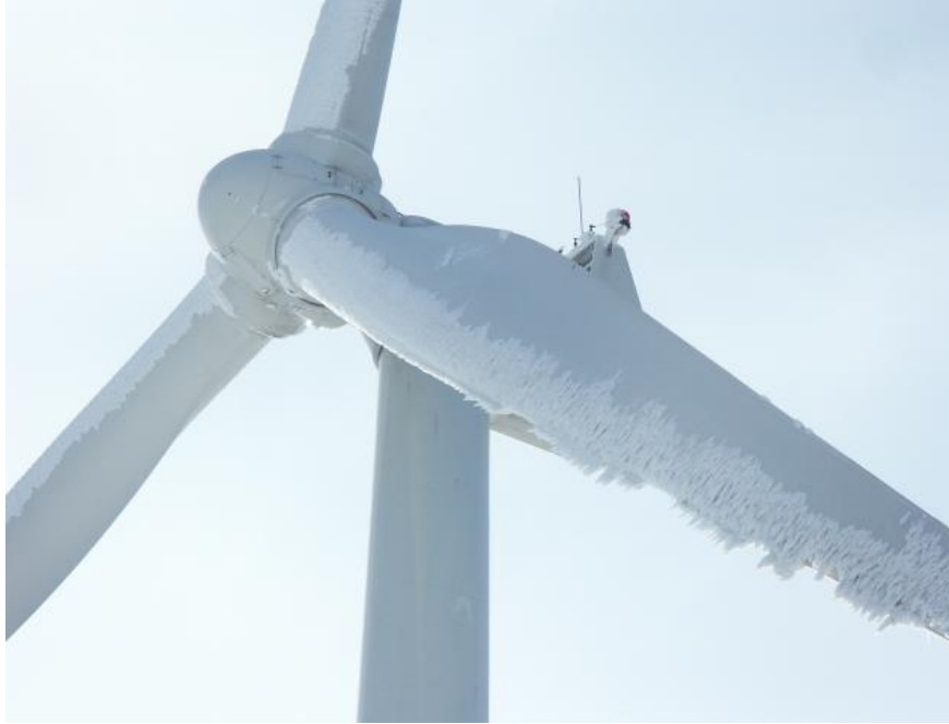
Fig. 1.12 – Formazione di ghiaccio sulle pale di una turbina eolica.
