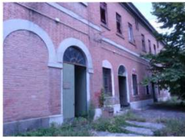
La casermetta ovest [edificio 1]
