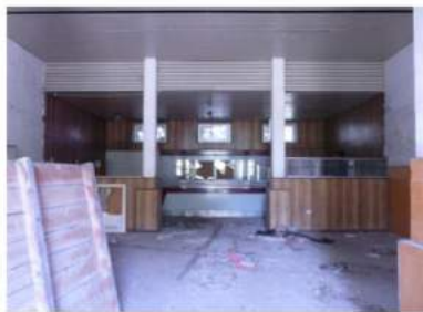
Ala sinistra, ingresso fronte sud
