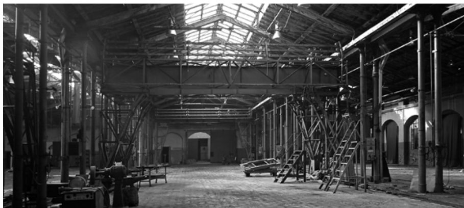
Ex Staveco, Bologna
