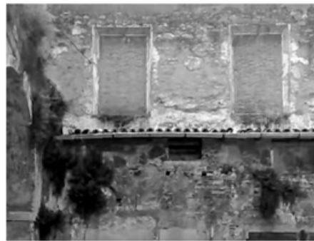
Vista interna, dettaglio delle finestre murate sul prospetto frontale
