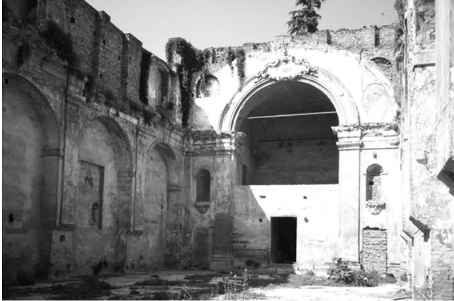
Interno, vista dell'abside
