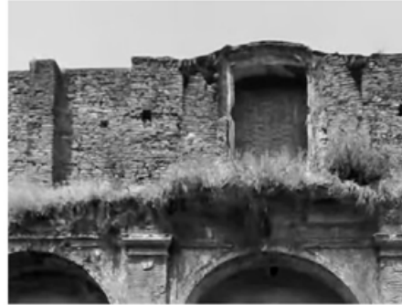
Vista interna, dettaglio della muratura superiore
