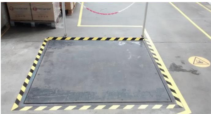
Figura 62 Suddivisione zone con nastri adesivi per pavimenti industriali
