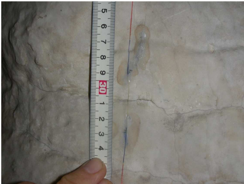
Fig 3.26 – Distanza punti di incollaggio fibra su fessura.
