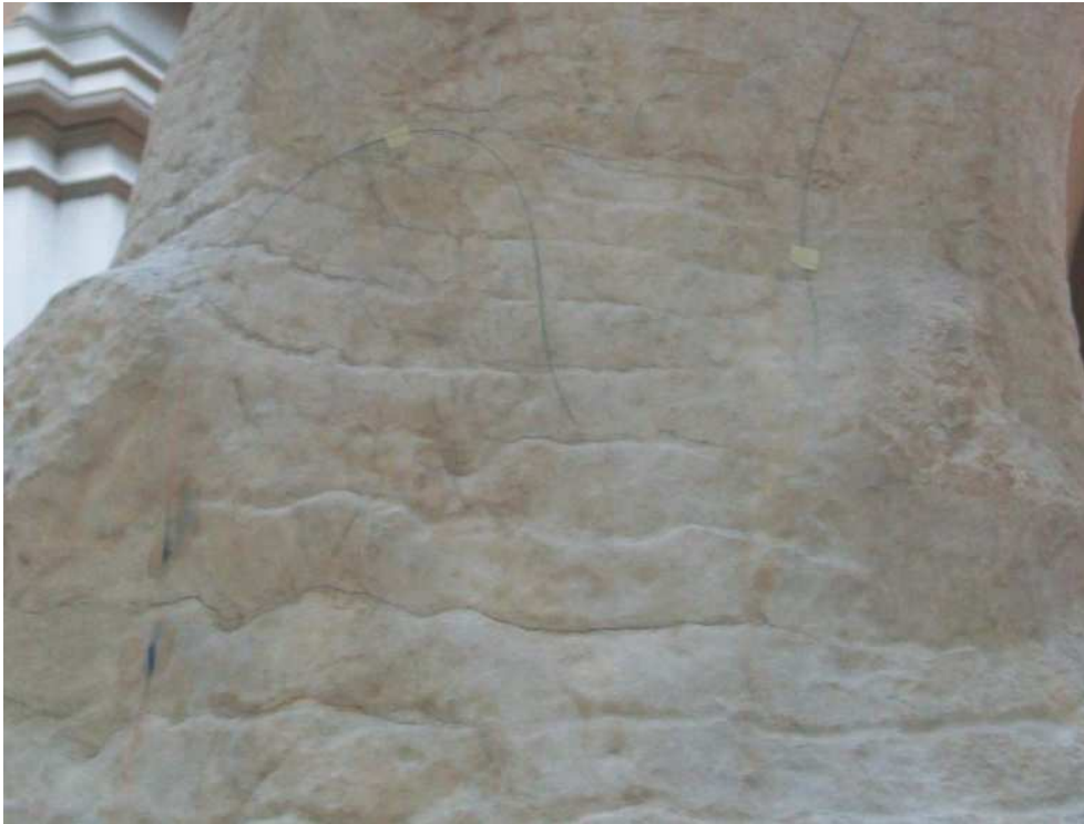
Fig 3.23 – Particolare fibra applicata sulla fessura.
