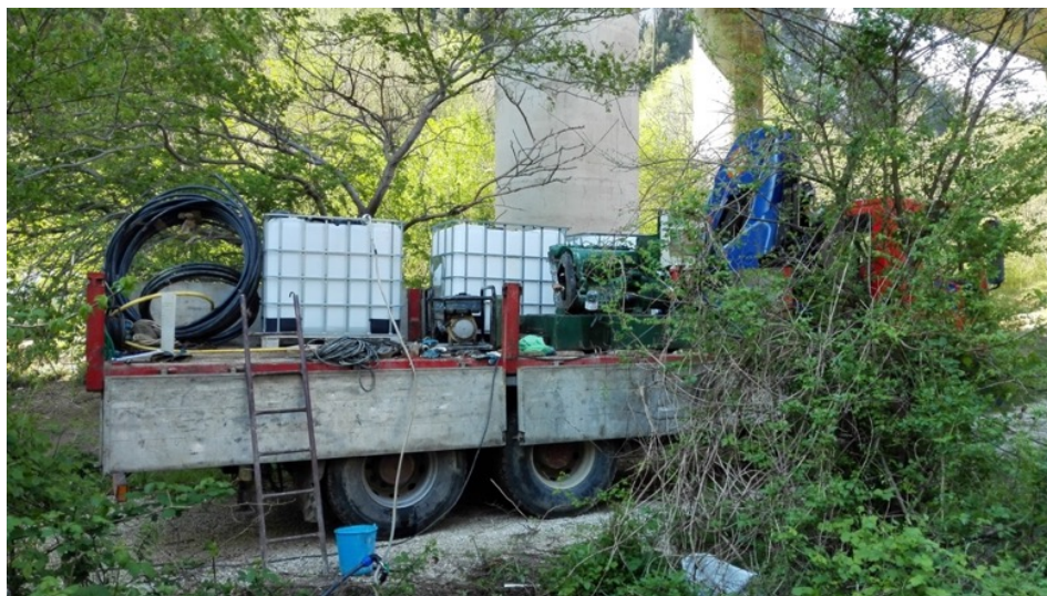
Figura 32: Operazione di spurgo al piezometro B3 con generatore e relative cisterne per lo smaltimento dell'acqua spurgata.
