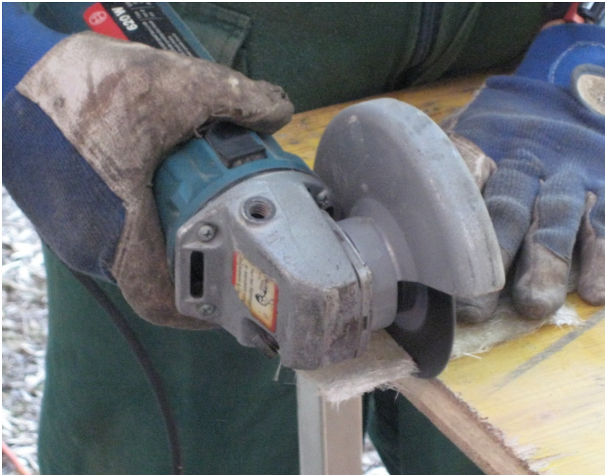
Figura 3.10 Operazioni di sagomatura del tallone con disco elettrico
