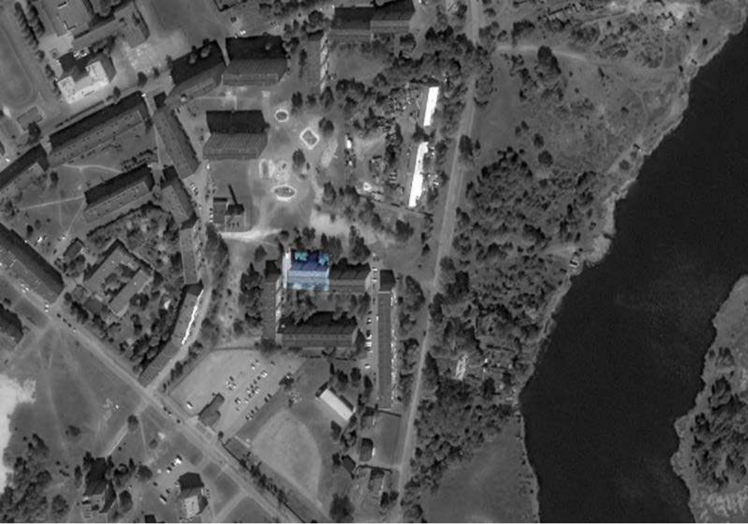
Vista satellitare del complesso con in evidenza l'edificio oggetto di studio.
