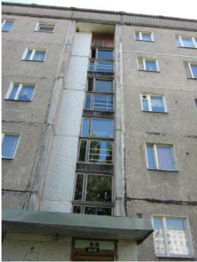
Facciata nord dell'edificio.
