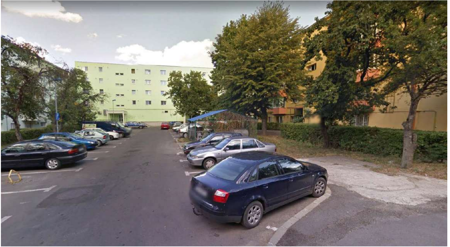
Vista del parcheggio antistante la facciata sud e dei due edifici adiacenti.
