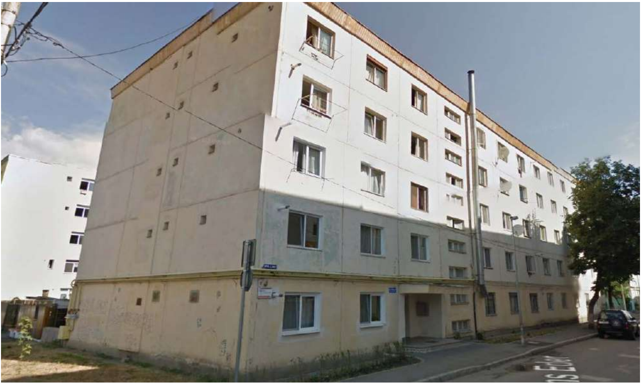
Vista della facciata sud-est con uno degli ingressi.
