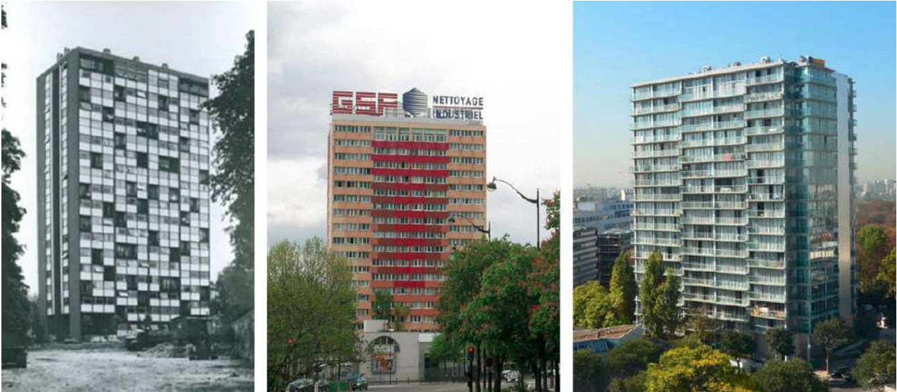
Fig. 1. Vista esterna di Tour Boise le Pretre subito dopo la costruzione, dopo la ristrutturazione del 1999 e dopo l'ultimo rinnovamento della facciata.
