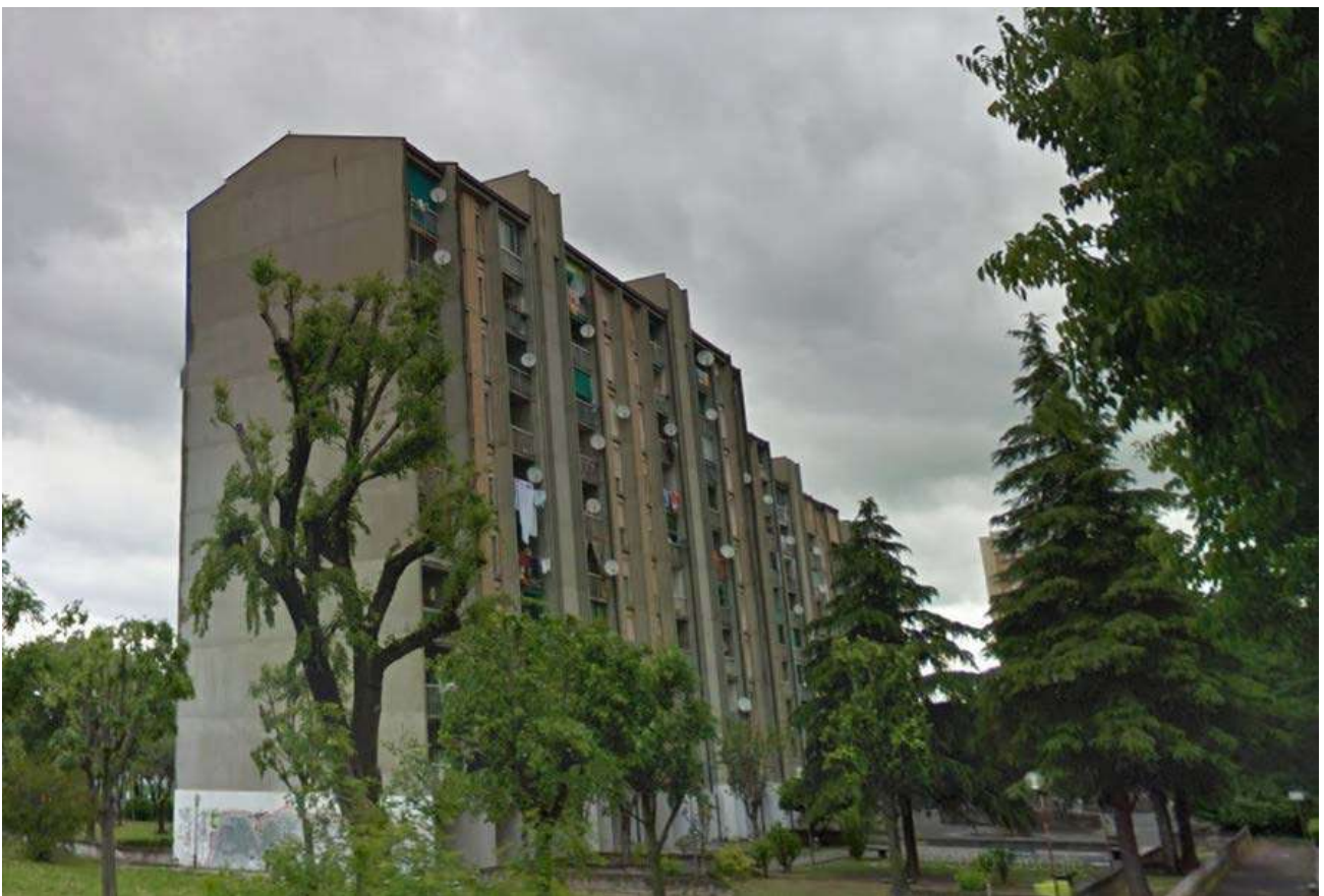
Viste del fronte stradale (ovest, in alto) e di quello retrostante (est, in basso).
