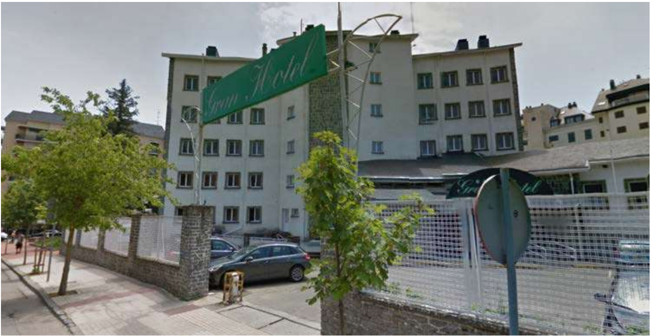
Vista del lato nord con il vano scala e l'ingresso dell'hotel.
