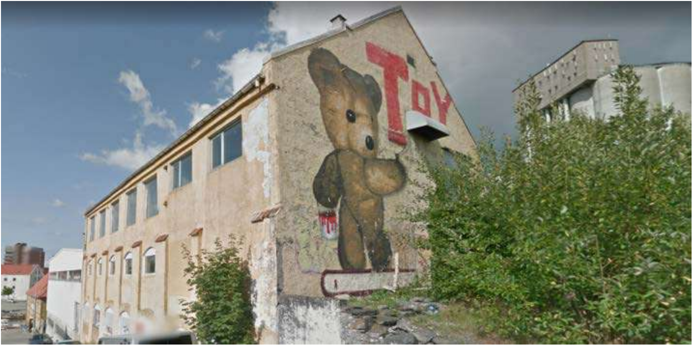
Vista della facciata ovest (longitudinale) e sud dell'edificio.
