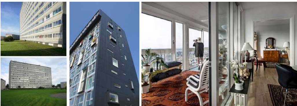
Fig. 5. Vista esterna complessiva e degli interni degli appartamenti prima e dopo il rinnovamento.
