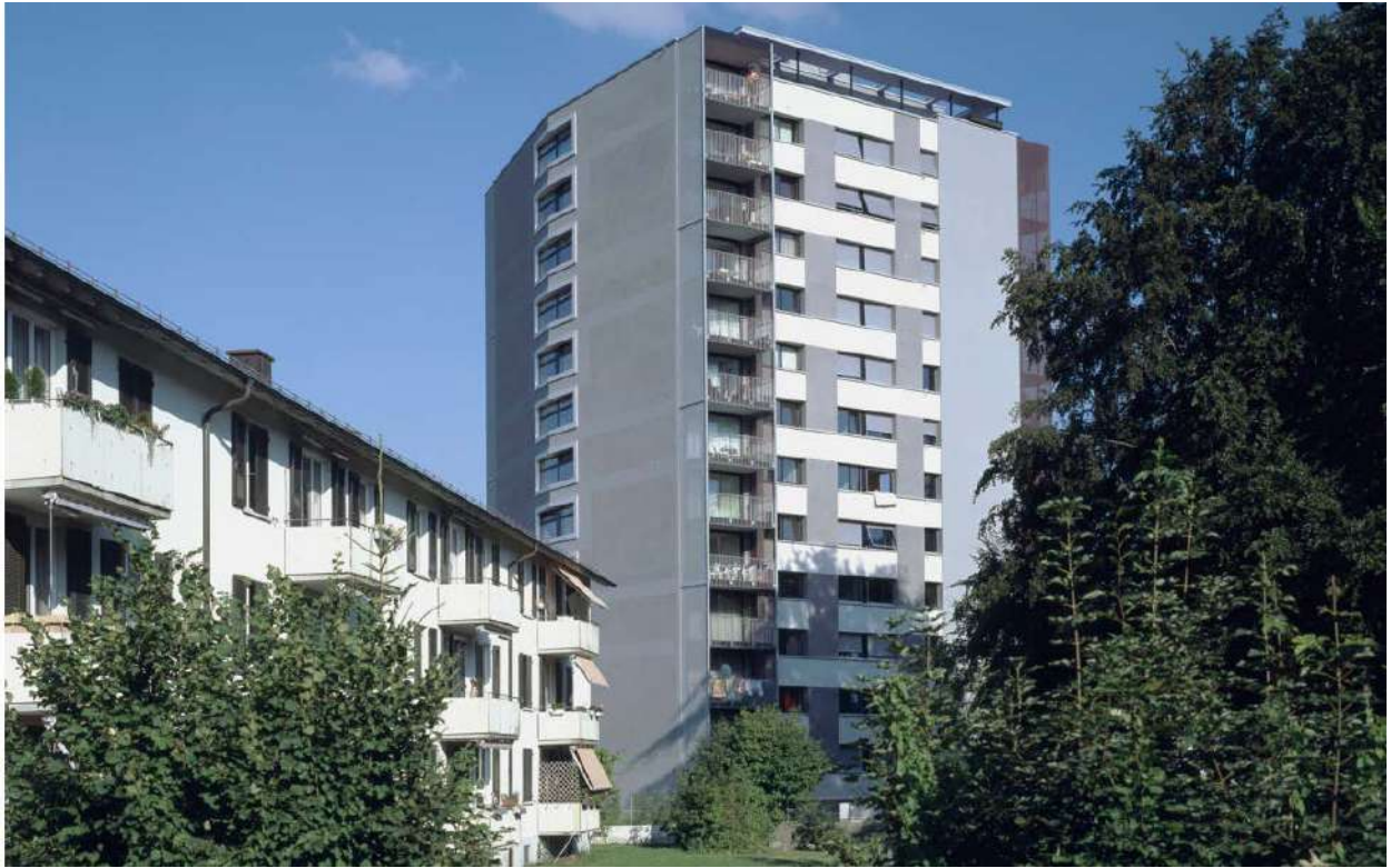
Vista degli interni e dell'esterno dell'edificio a seguito del rinnovamento.
