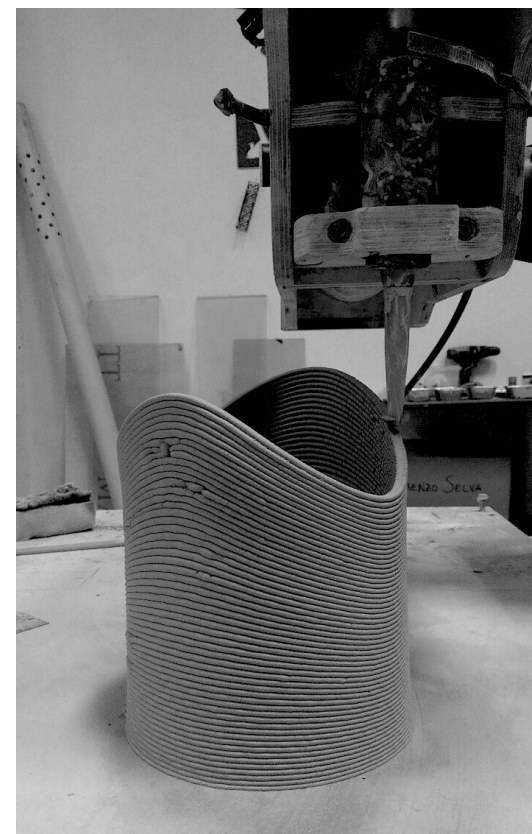
Robot w/ clay extruder, Digifabring, 2015: le due immagini mostrano la versatilità dei robot in architettura, personalizzandone i nozzle. Inoltre, è evidente come i processi additivi possano essere potenzialmente waste-free.
