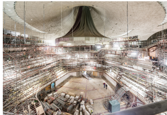
Elbphilharmonie, Hamburg, 2006-2016 - Herzog & De Meuron Arch. : complessità delle attuali opere di cantierizzazione
