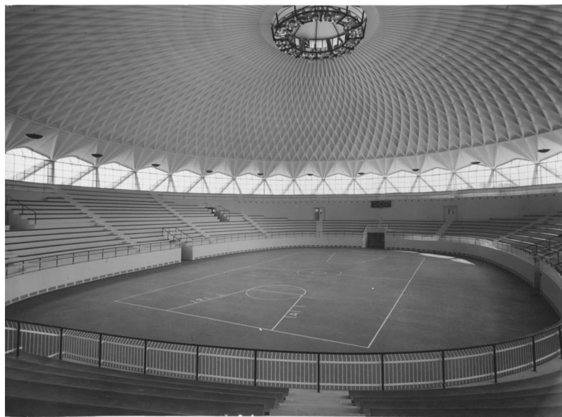
Palazzetto dello Sport, 1954-1957, Roma - P.L. Nervi: le nervature all'intradosso della copertura riproducono esattamente l'andamento locale delle tensioni
