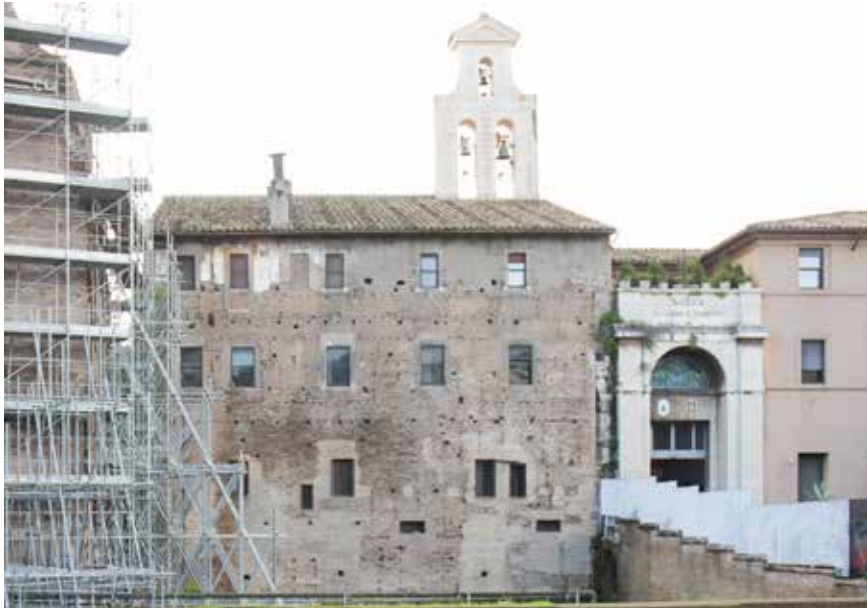
Fig. 10 - Muro del Tempio della Pace su cui era applicata la Forma Urbis Severiana, ora parte della Basilica dei Santi Cosma e Damiano. (Foto di Antonio Giaconia)
