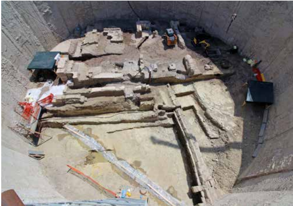
Fig. 2 - Pozzo 3.4 della Metro C di Roma presso piazza Celimontana. Alla profondità di 16 metri dal piano attuale è emerso un acquedotto di età repubblicana in blocchi di tufo squadrati collegato ad una grande vasca (Foto di Metro C scpa).
