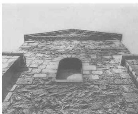
Fig. 3 - Elementi del linguaggio romanico. Il muro può essere in mattoni di cotto, collocati ordinatamente o a blocchi sconnessi connessi con malta di calce, opus spicatum (Tratto da Carlo Bassi, Percorsi nella storia della città e dell'Architettura: dalla Preistoria al 1750 )
