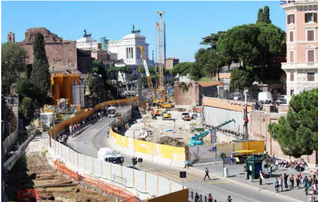
Fig. 3 - Cantiere della stazione Fori Imperiali della Metro C di Roma (Foto di Metro C scpa).
