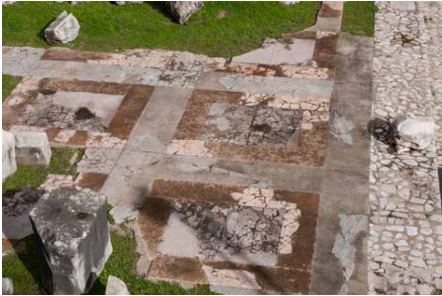
Fig. 7 - Pavimentazione esistente del portico di Augusto. (Foto di Antonio Giaconia)
