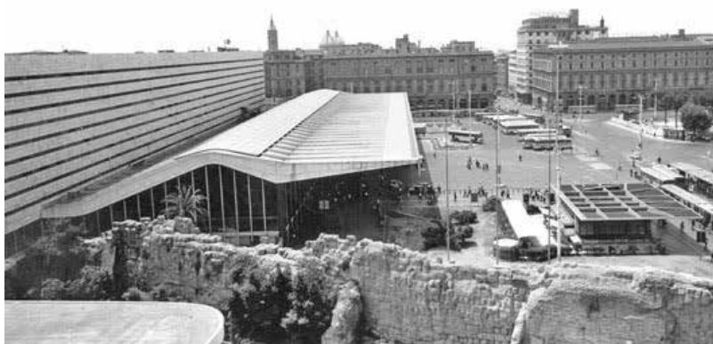
Fig. 13 - Vista esterna della stazione negli anni Cinquanta (Foto archivio storico FS).
