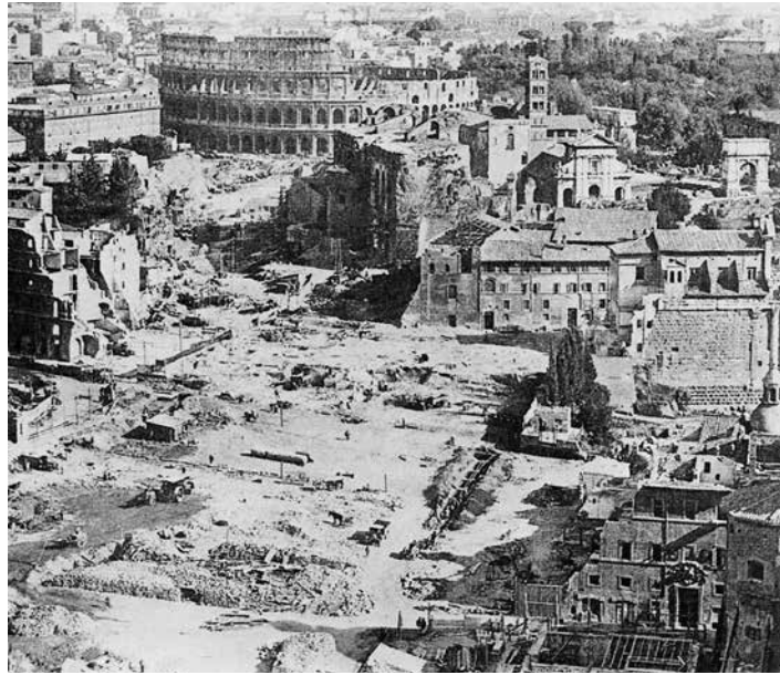
Fig. 6 - La demolizione del quartiere dei Pantani e lo sbancamento della collina della Velia sono quasi del tutto completati. Il terreno sarà pronto per la realizzazione della Via dell'Impero. (Tratto da: Raffaele Panella, Roma la città dei Fori. Progetto di sistemazione dell'area archeologica tra Piazza Venezia e il Colosseo , Roma, Prospettive Edizioni, 2013)
