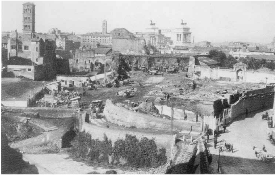
Fig. 5 - I lavori di spianamento della collina della Velia in una vista dal Colosseo, 17 Febbraio 1932. (Tratto da: Raffaele Panella, Roma la città dei Fori. Progetto di sistemazione dell'area archeologica tra Piazza Venezia e il Colosseo , Roma, Prospettive Edizioni, 2013)
