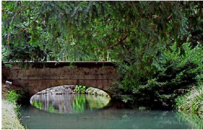
PONTICELLO OVALE, GIARDINO INGLESE CASERTA
