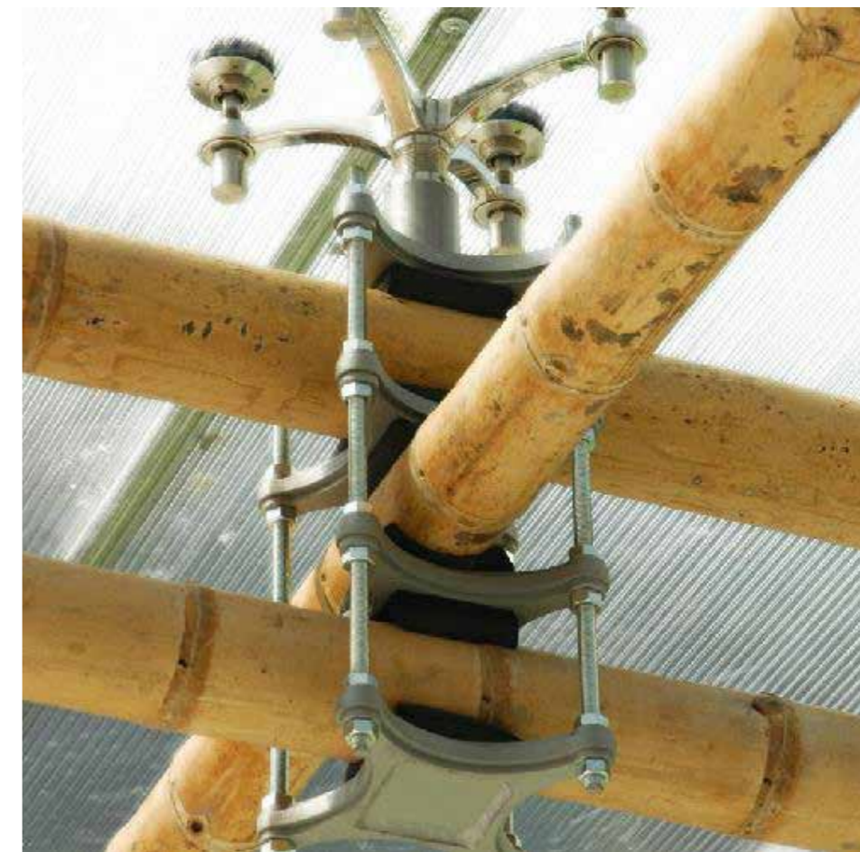
15- Sistema di fissaggio delle canne di bambù con complessi elementi in acciaio
