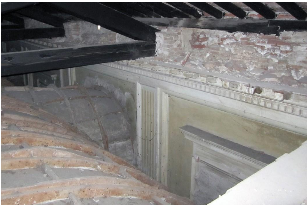
Fig. 16 - Particolare della decorazione originale (Arch. Poggioli, 2016)
