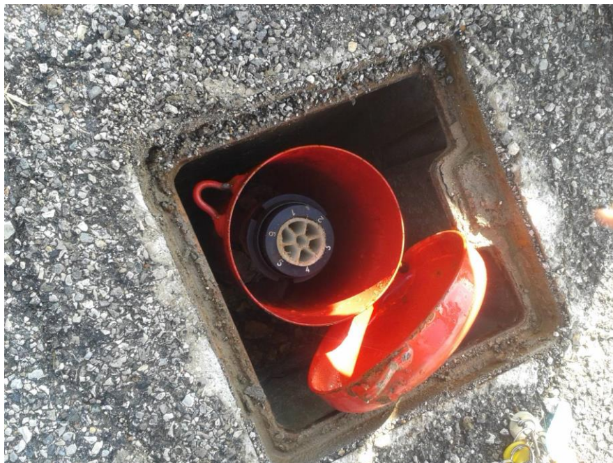
Figura 30. Foto del piezometro multilivello costituito da 7 porte.
