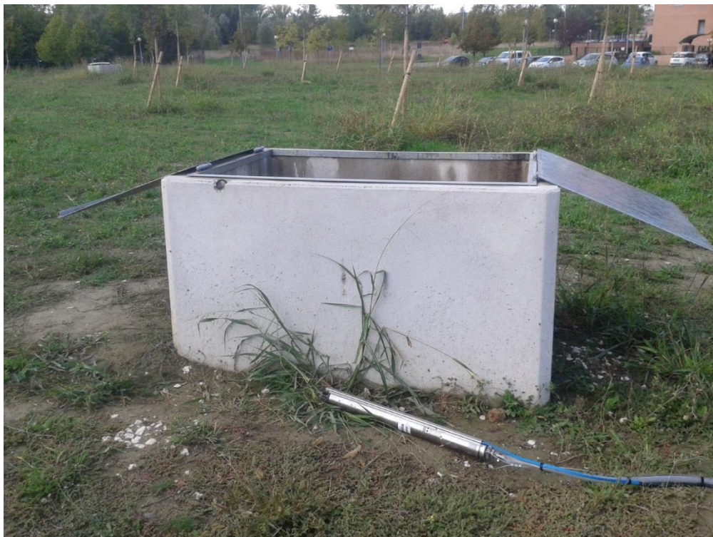
Figura 26. Particolare esterno del pozzo P1.
