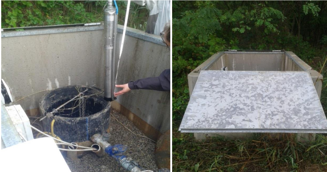
Figura 25. Immagine del pozzo P5 visto dall'esterno ( a destra) e particolare dell'interno (a sinistra).
