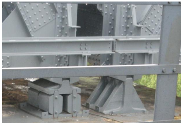
Figura 2.10 – Apparecchi di appoggio di estremità delle travate.
