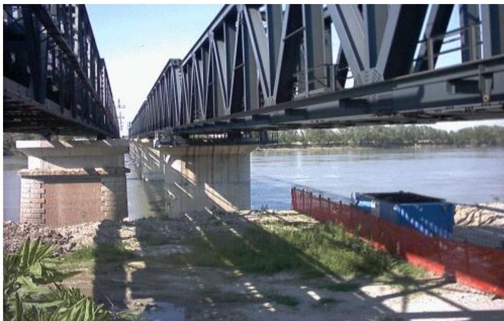
Figura 2.1 – Potenziamento della linea Bologna-Padova. Raddoppio del ponte ferroviario sul fiume Po in corrispondenza di Pontelagoscuro. Il vecchio ponte ferroviario potenziato a sinistra nella foto.
